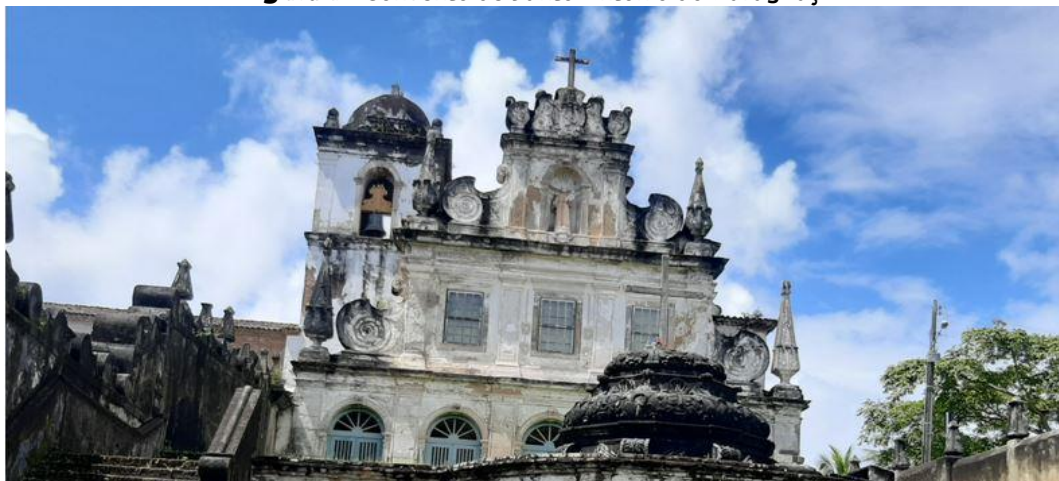
Figura 1 - Convento de Santo Antônio do Paraguaçu
