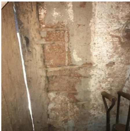
Figura 9 – Exposição da trama da taipa na (EDIF.6)
