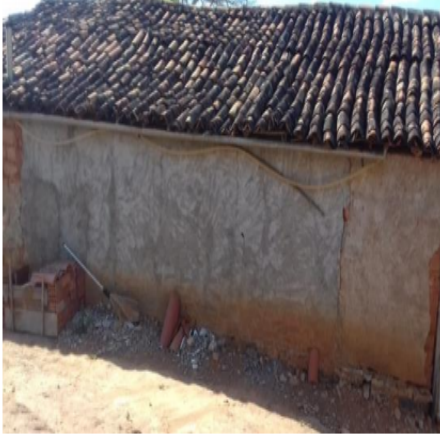
Figura 4 – Revestimento da parede externa da EDIF.6
