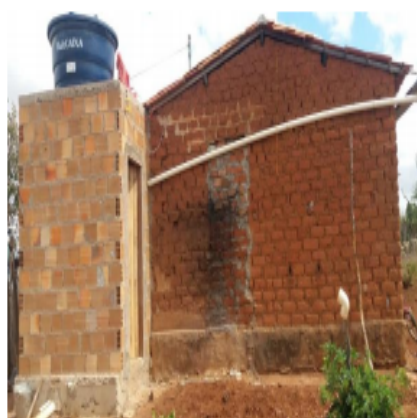
Figura 3 – Destaque para o bloco cerâmico e o adobe utilizados na EDIF.4
