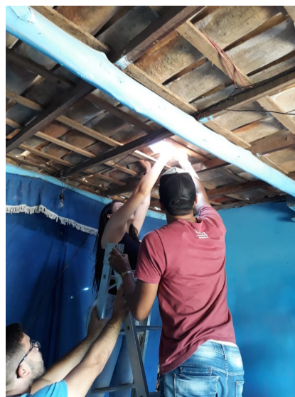
Figura 3 - Instalação das Telhas.
