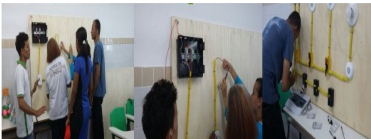
Figura 2- Aulas das oficinas de instalações elétricas
